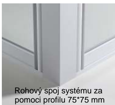
Napojování jednotlivých panelů
